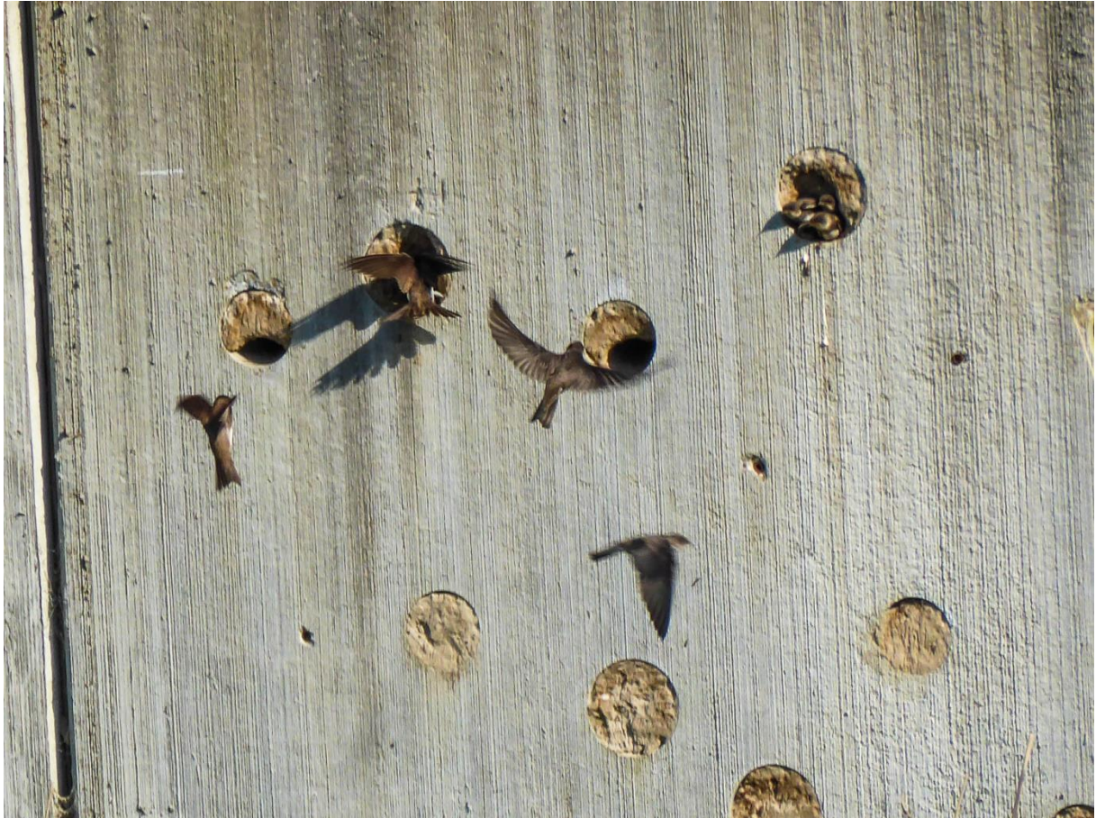
Oeverzwaluwen bij de kunstwand. Je ziet dat de voorgeboorde gaten in de betonwand groot genoeg zijn: de voorgeboorde gaten zijn 9 of 11 cm doorsnee, de nestholtes zijn ongeveer 5 cm breed en 3 cm hoog.
