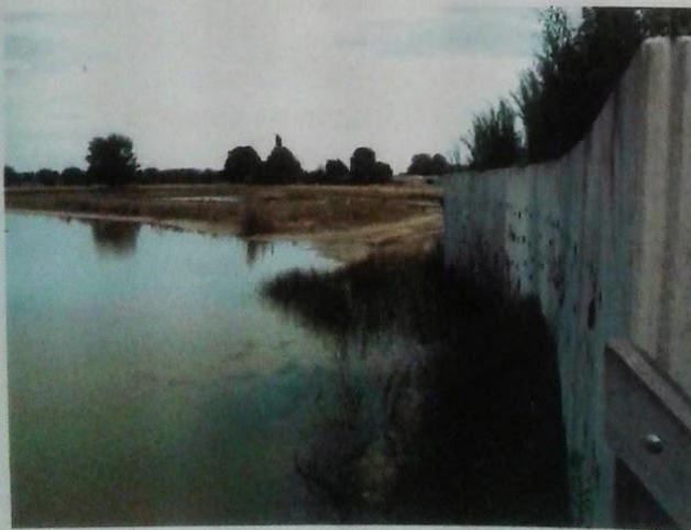
Foto: Oeverzwaluwwand begin augustus 2013.
