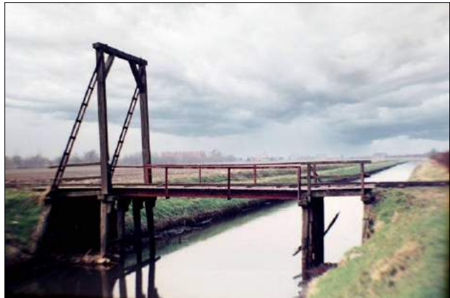
Brug Nieuwe Leidijk, waarschijnlijk midden jaren '60
